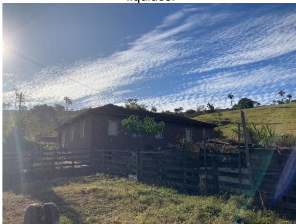
Figura 20: Vista da segunda residência desativada. Não possui sistema de tratamento de efluentes líquidos.
