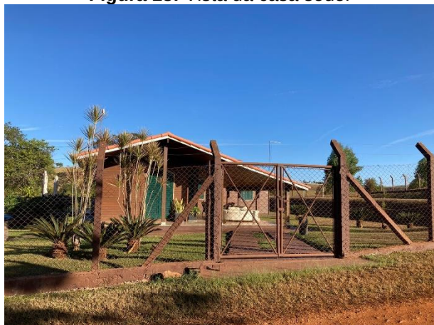
Figura 13: Vista da casa sede.
