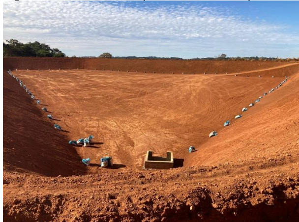
Figura 05: Estrutura do piscinão sendo implantado.
