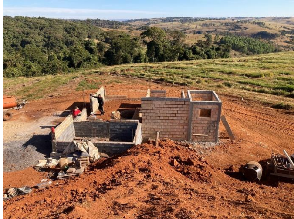
Figura 06: Estruturas da casa de bomba e depósito de defensivos sendo instalados.
